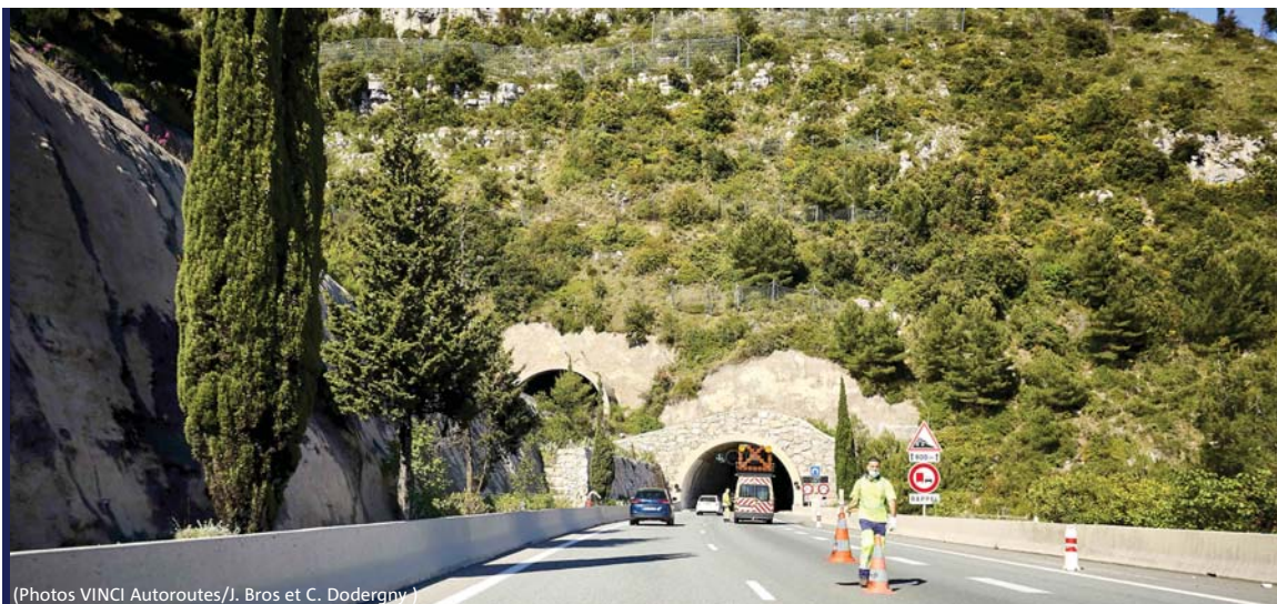
(Photos VINCI Autoroutes/J. Bros et C. Dodergrny)
