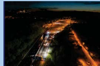
toulonnaise COLAS pour son chantier de rénovation des chaussées sur l'A8, entre Brignoles et Cabasse et sur l'A50, entre Bandol et La Ciotat.
