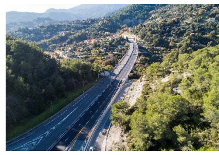
Ouverture de la nouvelle bretelle de Menton à la circulation le 20 déc. 2024
