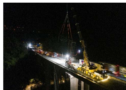
Installation des plateformes de travail
