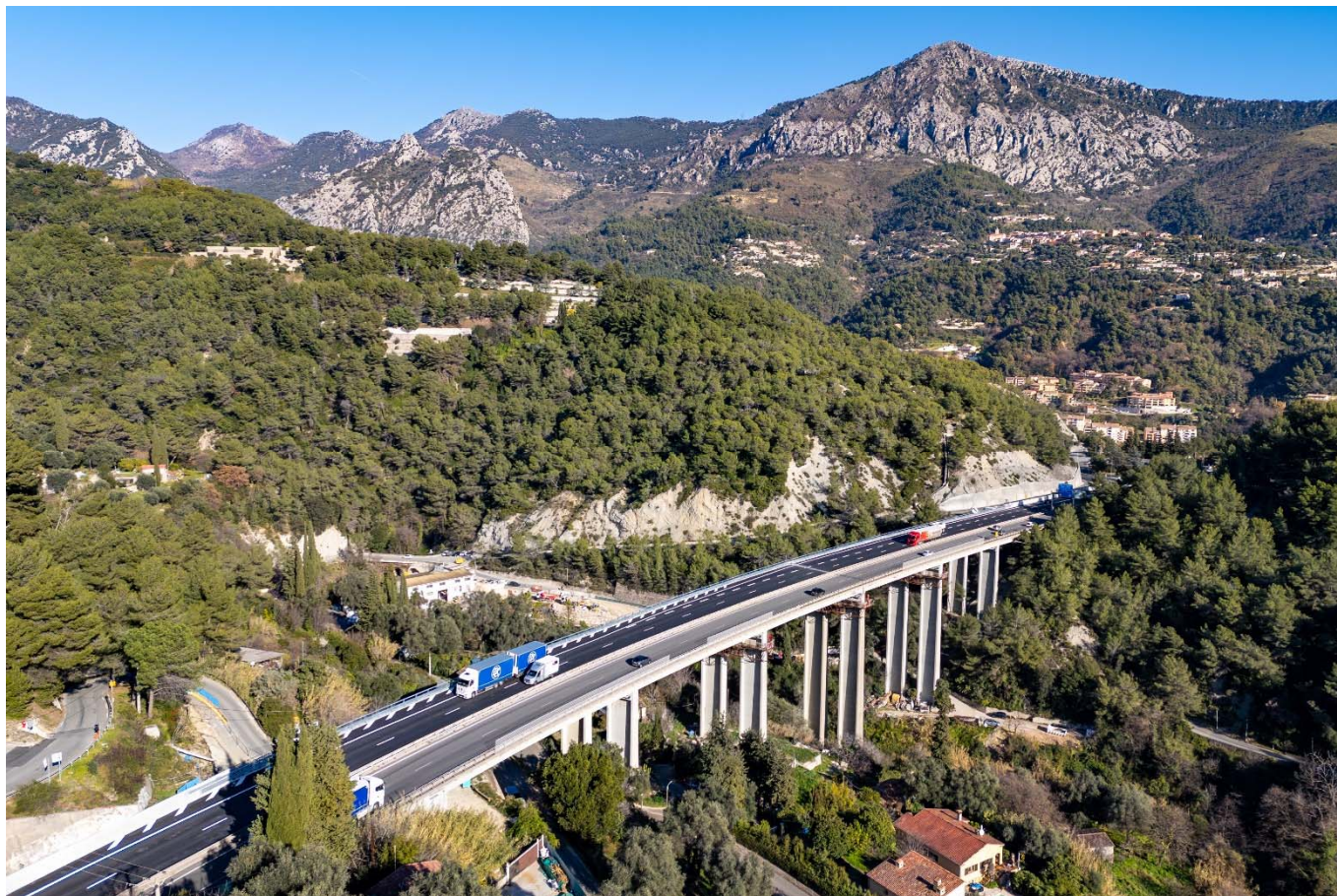
Nouvelle bretelle d'insertion de l'échangeur de Menton – 20 décembre 2024 @studio619
