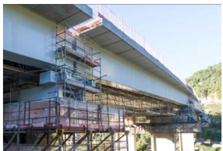
Élargissement du tablier du viaduc de Cabrolles
