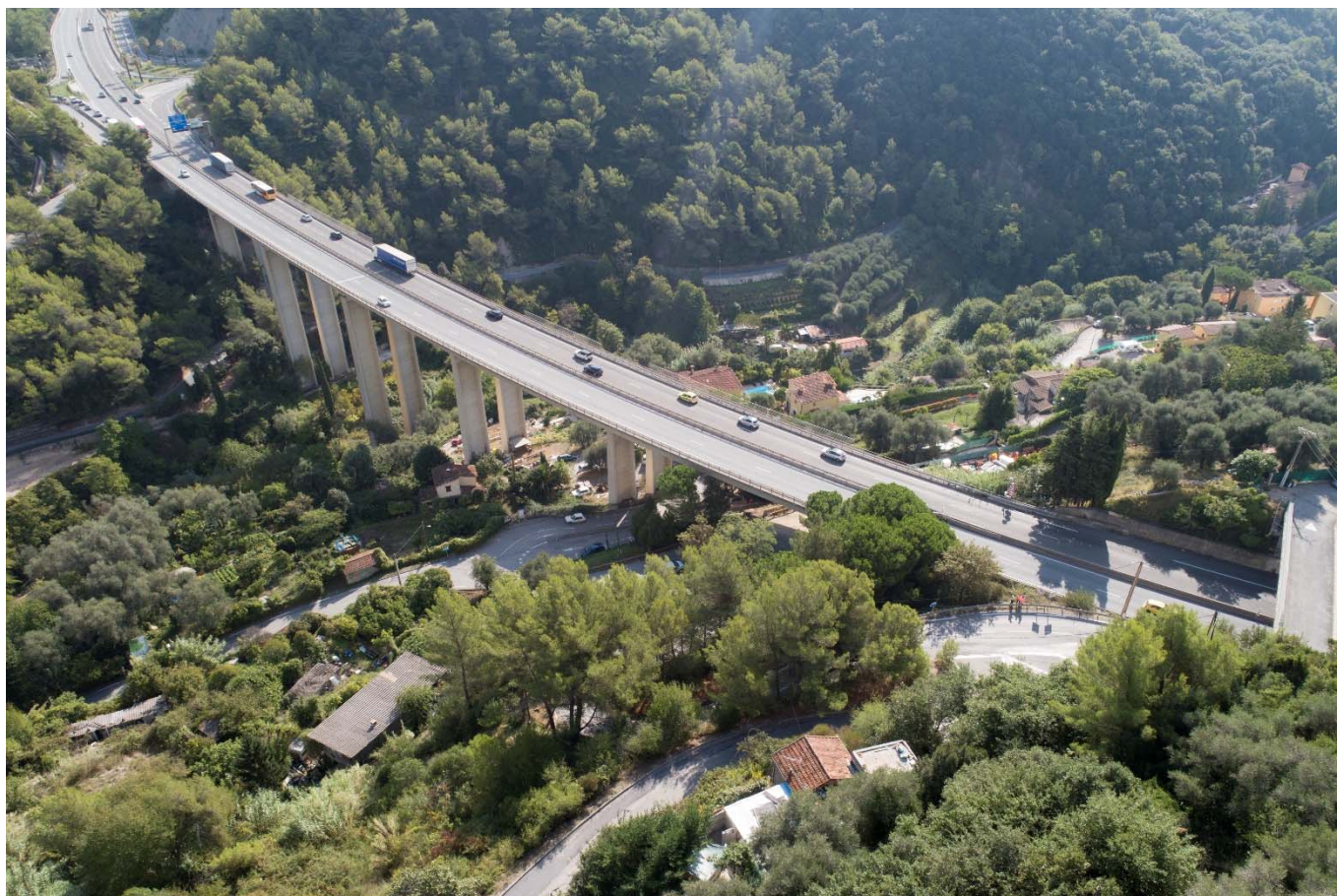
Situation avant travaux – octobre 2019
