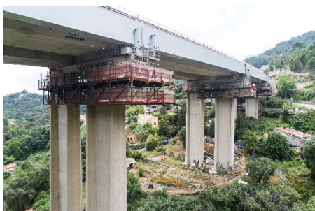
Vue des caissons posés le long du viaduc de Cabrolles
